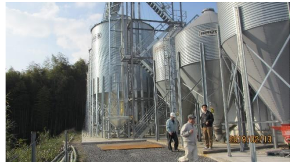
新設備が2月に竣工しました。
