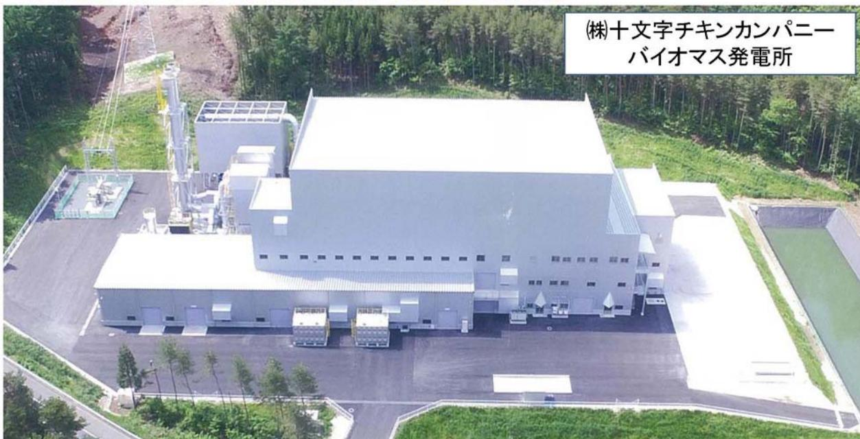
1日約400トンの鶏糞を燃焼して得られる電力6,250kwのうち、十文字チキンカンパニーの自家消費分を除く全量4,800kw(約1万世帯が使用する電力に相当)を株)パルシステム電力が購入。
